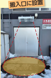
搬入口に設置
