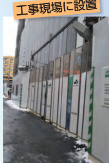
工事現場に設置
