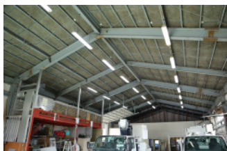
折板屋根 倉庫
